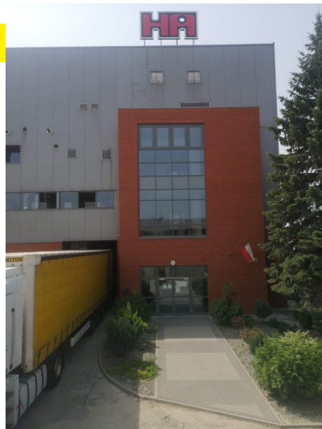
Rys. 12. Budynek biurowy HA Polska Fig. 12. HA Polska office building
